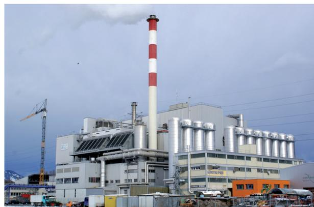
Im Sommer 2014 wurden die letzten 4 Speicher (Warmwasser bis 150°C) von insgesamt 12 Speichern in Betrieb genommen. Wasserinhalt pro Speicher ca. 200 m<sup>3</sup>; Wärmeinhalt der 12 Speicher insgesamt 240'000 kWh; Heizöläquivalent von ca. 28'000 Liter. Die Speicher werden übers Wochenende resp. nachts aufgeladen, um tagsüber die Spitzen abdecken zu können; es muss somit kein Öl verbrannt werden.
