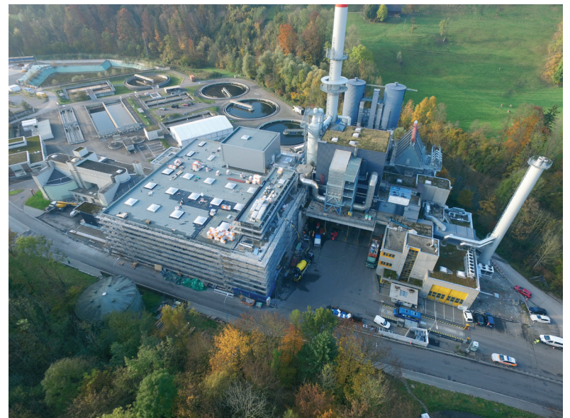
Die KHK kurz vor Bauende
